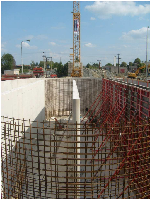
armatura stěn biobloku
