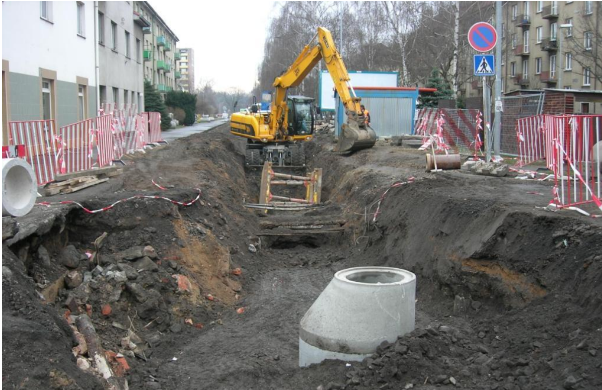
Stavební práce v Pichlově ulici
