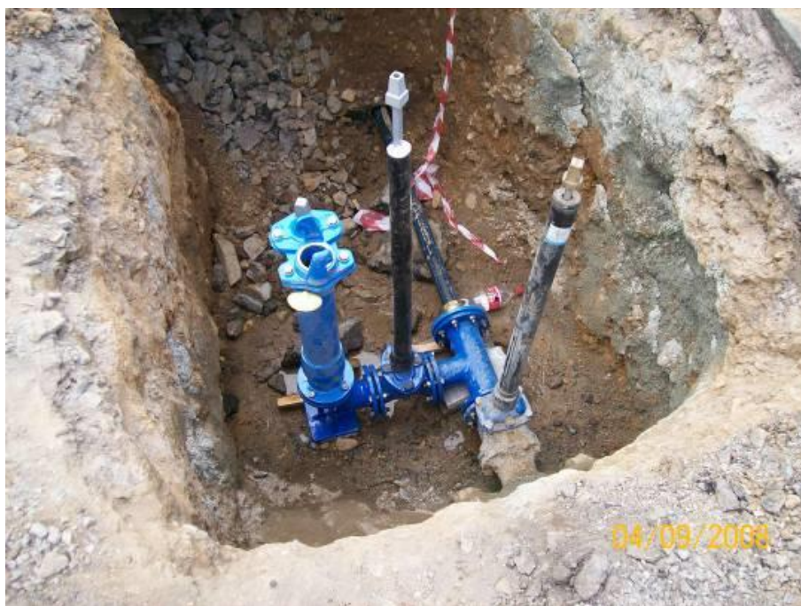
Obrázek 21: Napojení podzemního hydrantu na vodovodní řad.
