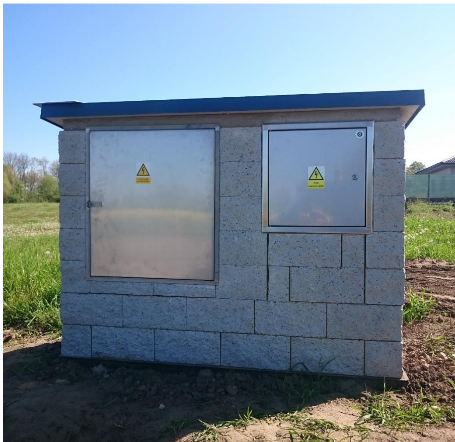
Obrázek 40: Vzorový zděný rozvaděč.
