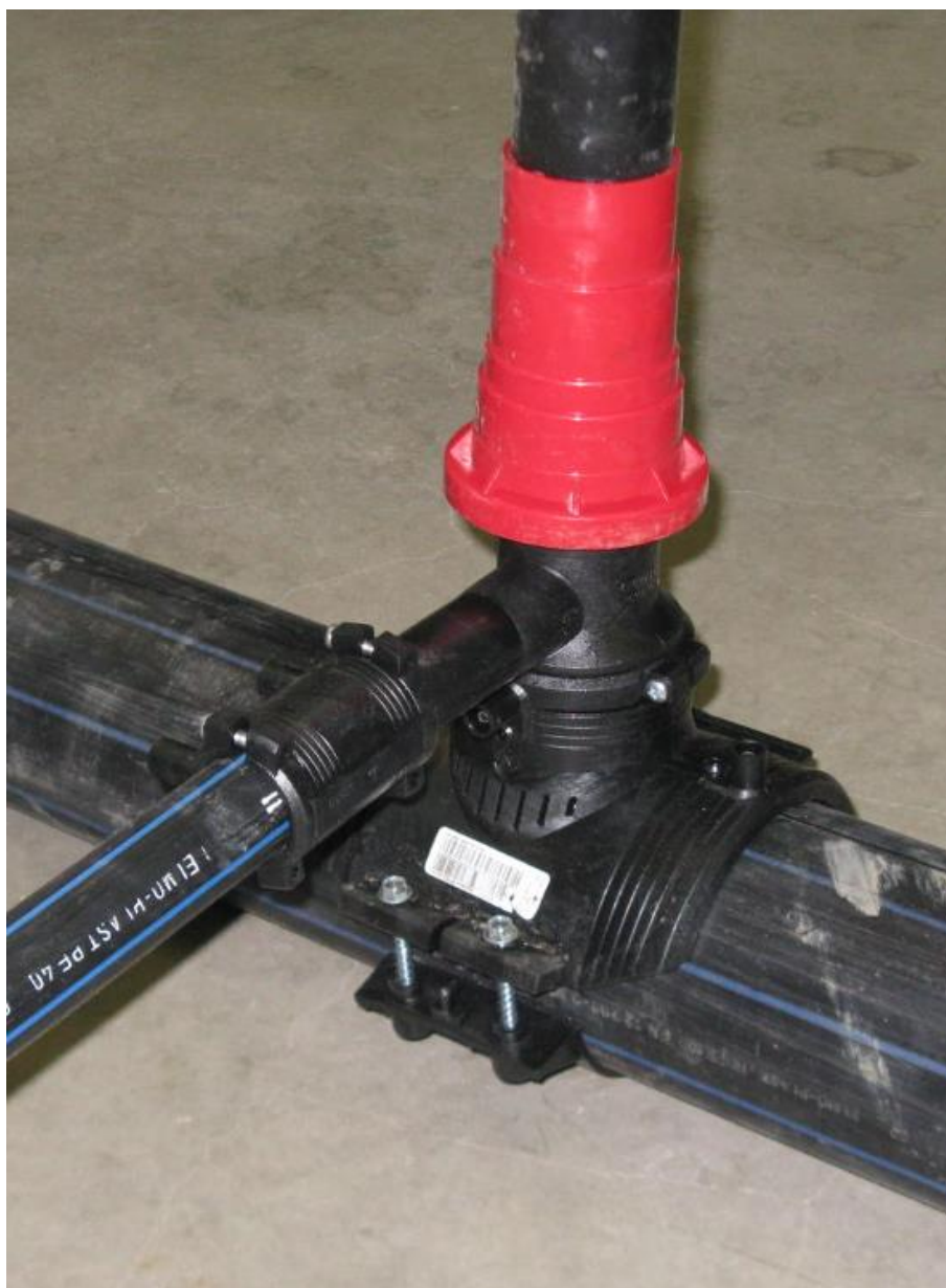
Obrázek 23: Navařovací navrtávací pas na vodovodním řadu z PE.
